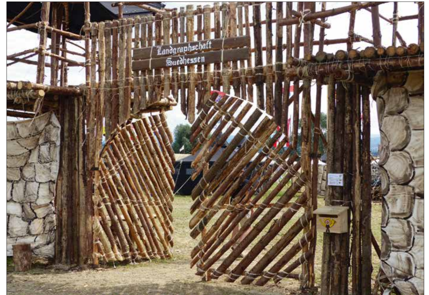
Das Lagertor der Landgraphschäft Südhessen wurde in der bewährten Lagerbauweise der Pfadfinder aus Stangenholz und Naturseil gebaut.
